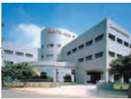
台中FA中心 Taichung FA Center MITSUBISHI ELECTRIC TAIWAN CO.,LTD
